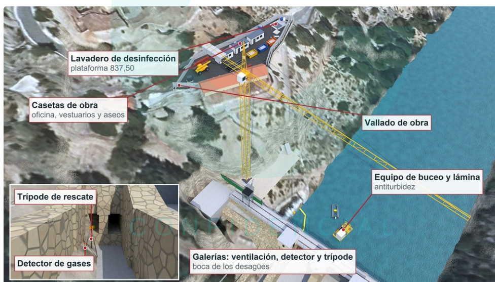
Figura 1.9. Implantación y medios de seguridad en agosto de 2027: casetas y lavadero en la plataforma 837,50, vallado, línea de vida en coronación, equipo de buceo con lámina antiturbidez y, en el recuadro, trípode de rescate y detector de gases en la boca de las galerías.
