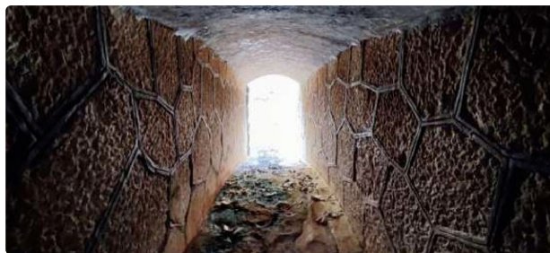
Fotografías del emplazamiento. Salida de los dos conductos al canal común, por donde entrarán compuertas, virolas y cuadrillas (izquierda), e interior de un conducto de 1,50 m de anchura, que se trabajará como espacio confinado (derecha).
