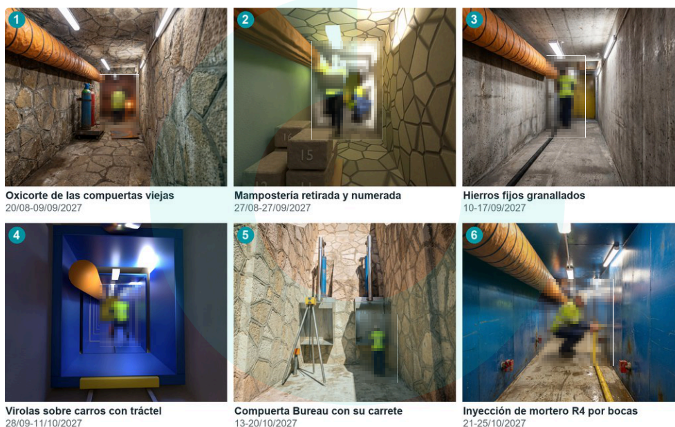
Figura 1.5. Galería de un desagüe en sus seis tajos principales, de aguas abajo hacia el embalse, con un máximo de 5 personas por conducto, extractor, detector de gases y luz a 24 V.
