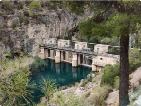
Fotografías del emplazamiento. Presa desde aguas arriba, con las casetas de accionamiento de las compuertas vagón en coronación y la cámara de toma en el estribo (izquierda), y paramento de mampostería de aguas abajo, que la obra protegerá y limpiará (derecha).
