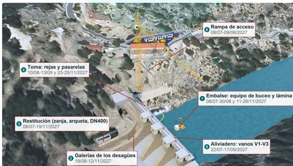
Figura 1.4. Campaña de 2027 el 24/08/2027: los seis frentes de trabajo con sus fechas (embalse con equipo de buceo y lámina antiturbidez, galerías de los desagües, restitución al río, obra de toma, aliviadero y rampa), servidos por la grúa torre de 55 m sobre el cimiento existente.
