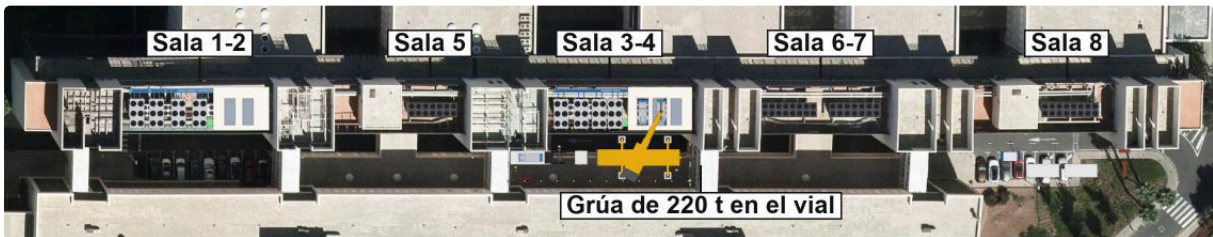
Figura 3.2. Planta de la central sobre ortofoto: salas 1-2, 5, 3-4, 6-7 y 8 y grúa de 220 t en el vial interior sur
