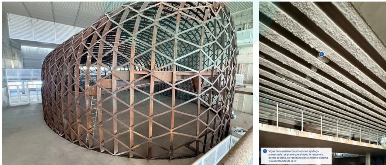
Figura 1.3. Estado actual del salón de plenos: a la izquierda, el ovoide de acero corten sobre la platea de entreplanta, que se reforzará por dentro y por fuera evitando soldar a la vez por sus dos caras; a la derecha, las vigas de la platea con su protección ignífuga proyectada, que el apeo respetará y que se restituirá con el mismo sistema donde un taladro o una soldadura la daña.
