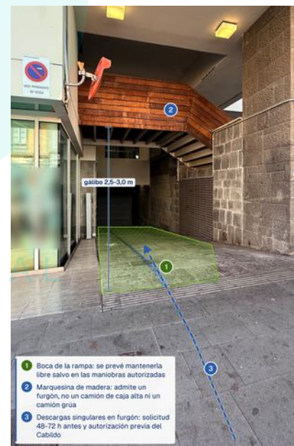
Figura 1.11. Rampa del garaje de consejeros: por ella solo entrará un furgón en descargas singulares, pedidas con 48-72 h de antelación y autorizadas por el Cabildo cada vez; el resto del tiempo la boca quedará libre.
