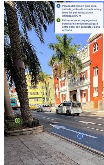
Figura 1.10. Calzada de C/ Bravo Murillo junto a la zona de obra: los camiones pararán entre las palmeras y el camión grúa descargará con la pluma limitada a 5,0 m, con señalista y zona acotada.
