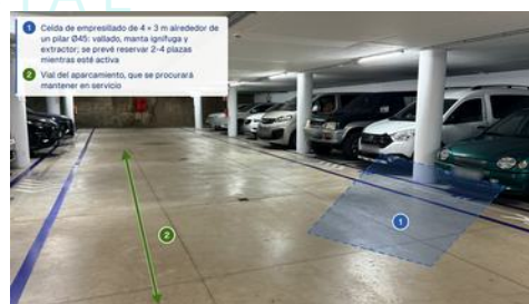
Figura 1.16. Aparcamiento del sótano -1 en uso: los pilares Ø45 se empresillarán en celdas de 4 x 3 m, de una en una, con vallado, manta ignífuga y extractor, y solo con 2-4 plazas reservadas mientras la celda esté activa; el vial se mantendrá en servicio.
